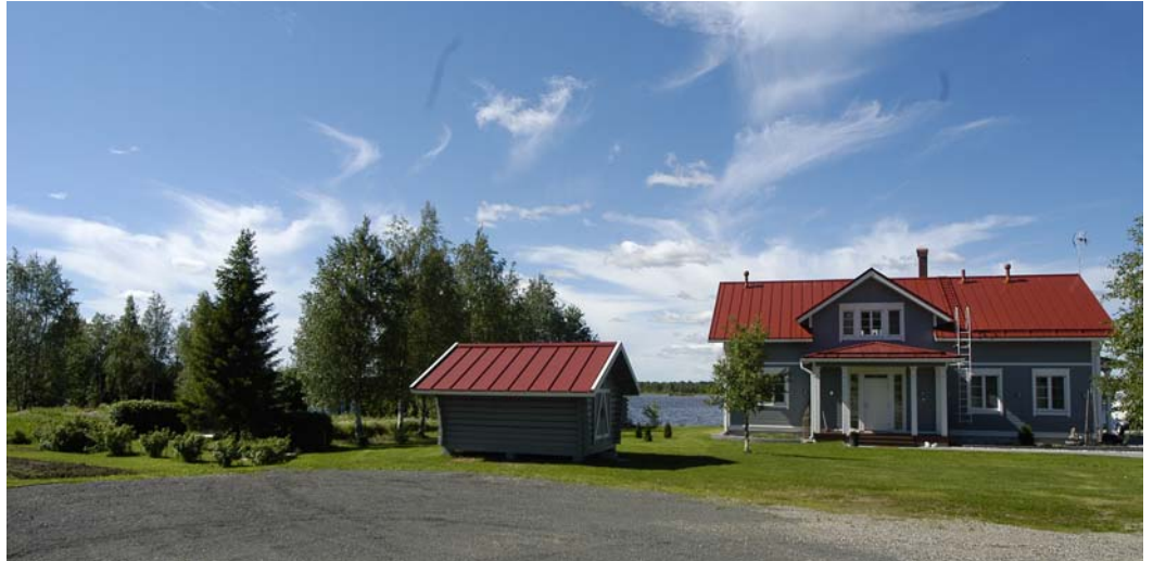
Kuva 8. Kemijoen rannalle toteutettu uusi asuinrakennus.
